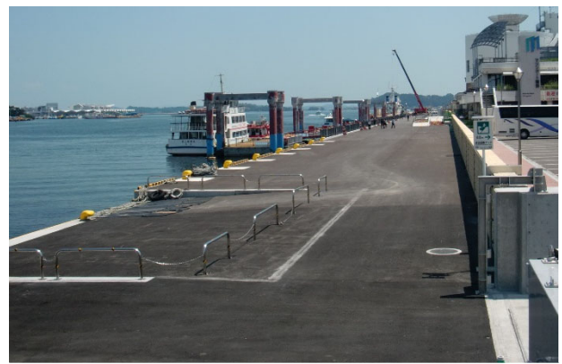
西ふ頭観光棧橋復旧完了写真
