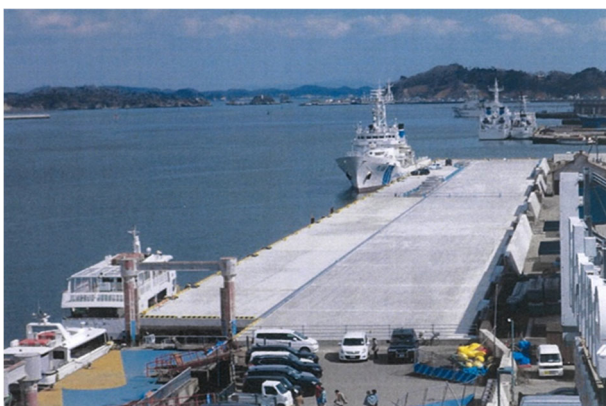
西ふ頭棧橋復旧完了写真
