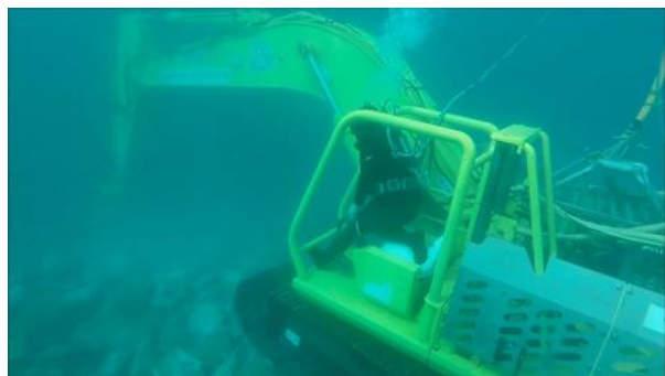
図1 海洋土木工事における潜水士の人力作業と、水中バックホウによる機械化
